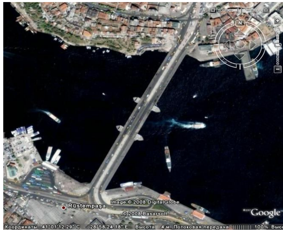
Рис. 6. Мост в Стамбуле, Турция, пролив Босфор
